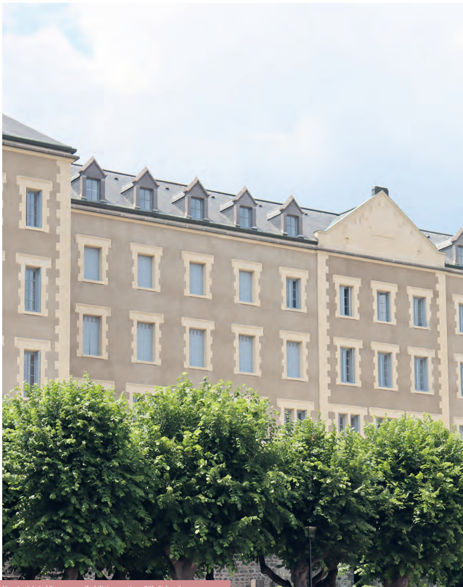
L'ancien hôpital Fontmaure réhabilité en partie en Pôle Culturel.
